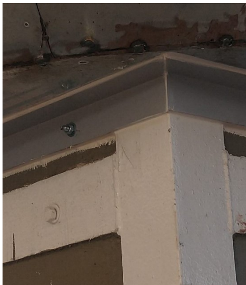
Foto 4: Visão da cantoneira instalada sob os cones invertidos.
