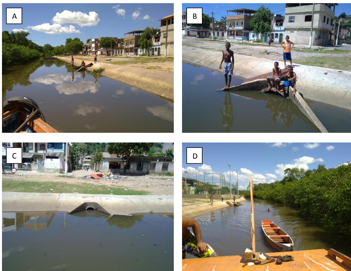
FIGURA 20 – Zona de lançamento de água de drenagem urbana, mas atualmente contaminada pela descarga de esgoto in natura proveniente de ligações clandestinas. Em A e B é observada a presença de crianças sobre a manilha de lançamento; em C é mostrado o ponto de lançamento de água de drenagem / esgoto no “valão”; em D é possível visualizar a presença de crianças em contato primário com a água contaminada.
