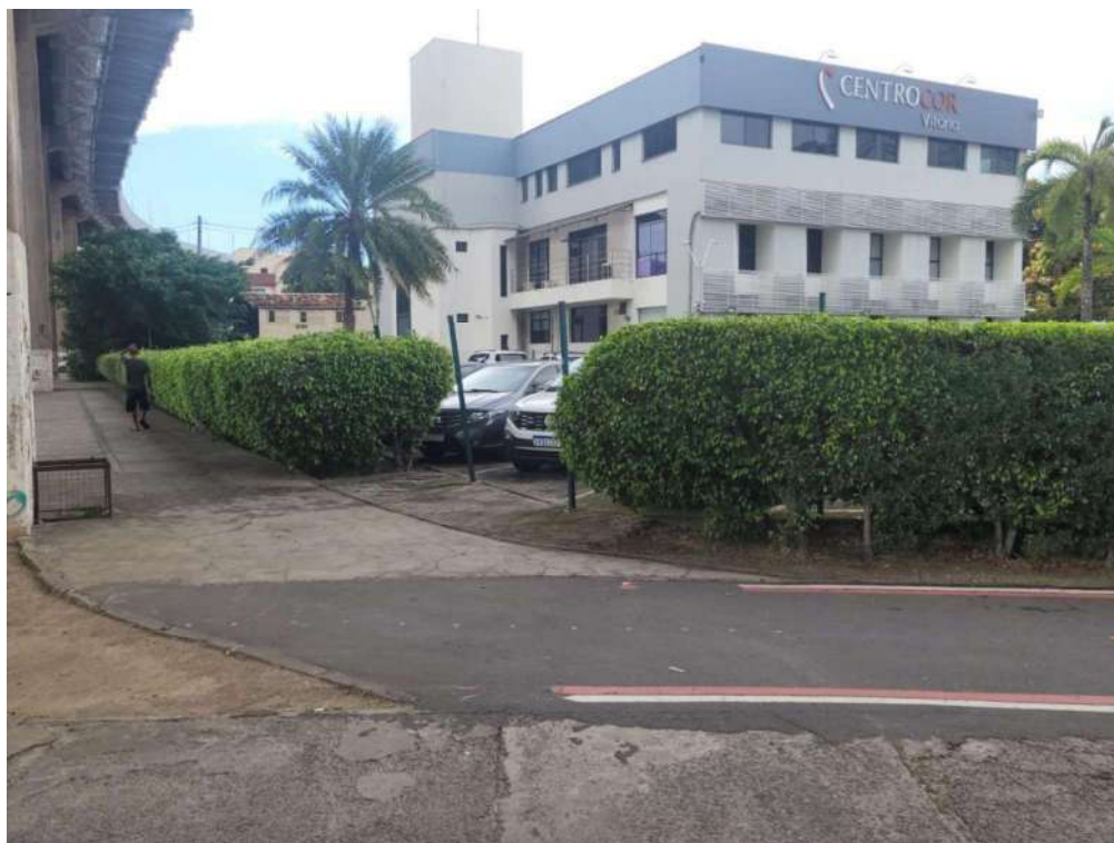
VISTA LATERAL DO LOTE
