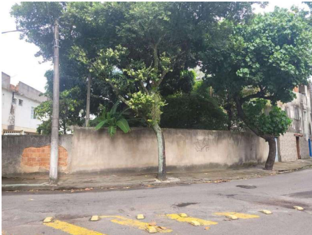
VISTA LATERAL DO LOTE
